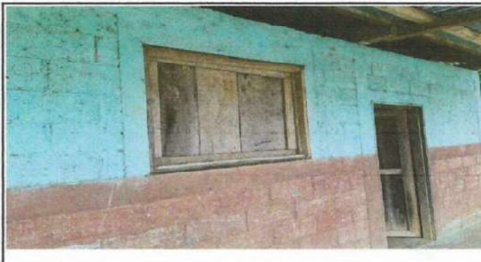
Foto 4: SUSTITUCION DE VENTANAS Y PUERTAS DE MADERA A METAL
